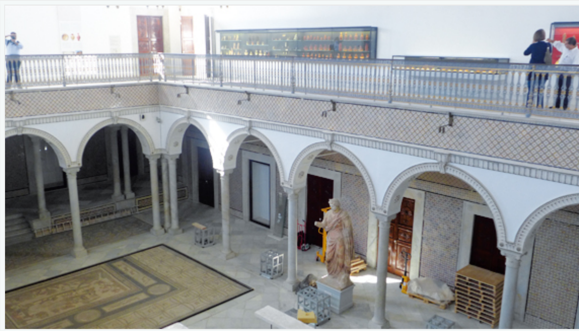
La Salle de Carthage en cours de rénovation.
